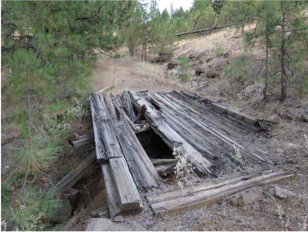
13wp15 Old bridge.JPG
